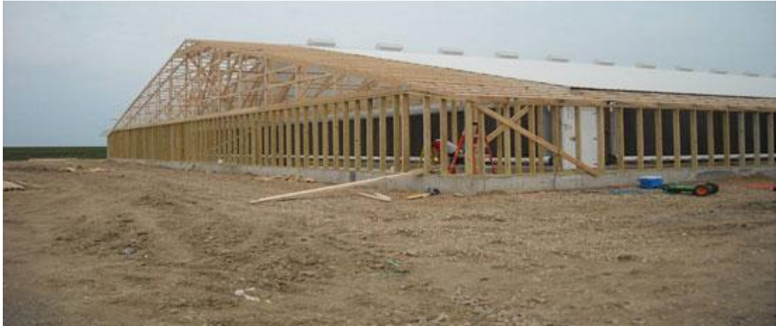
Foto 3: Construcción del almacén para la instalación de los bancos de filtros en una granja de madres en Norte América. Cortesía de Kent Unke (Biosecure Aire Inc.)
